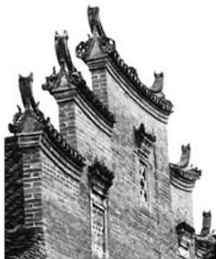
马头墙，是徽派建筑的重要特色。在聚族而居的村落中，民居建筑密度较大，不利于防火的矛盾比较突出，而高高的马头墙，能在相邻民居发生火灾的情况下，起着隔断火源的作用，故而马头墙又称之为封火墙。
